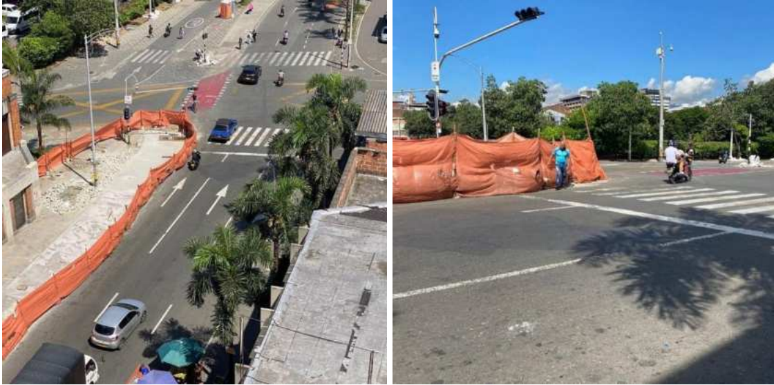
Imagen 24. Fotografías intersección Avenida de Greiff con Avenida Cundinamarca - Contrato 4600094538.
